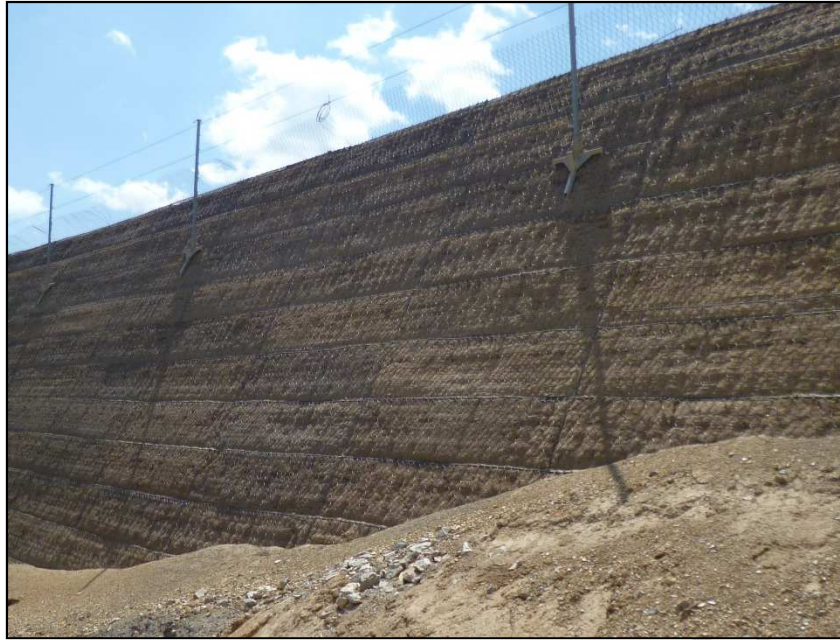
Fig. 40 – Rivestimento di terreno al piede per proteggere il rilevato
