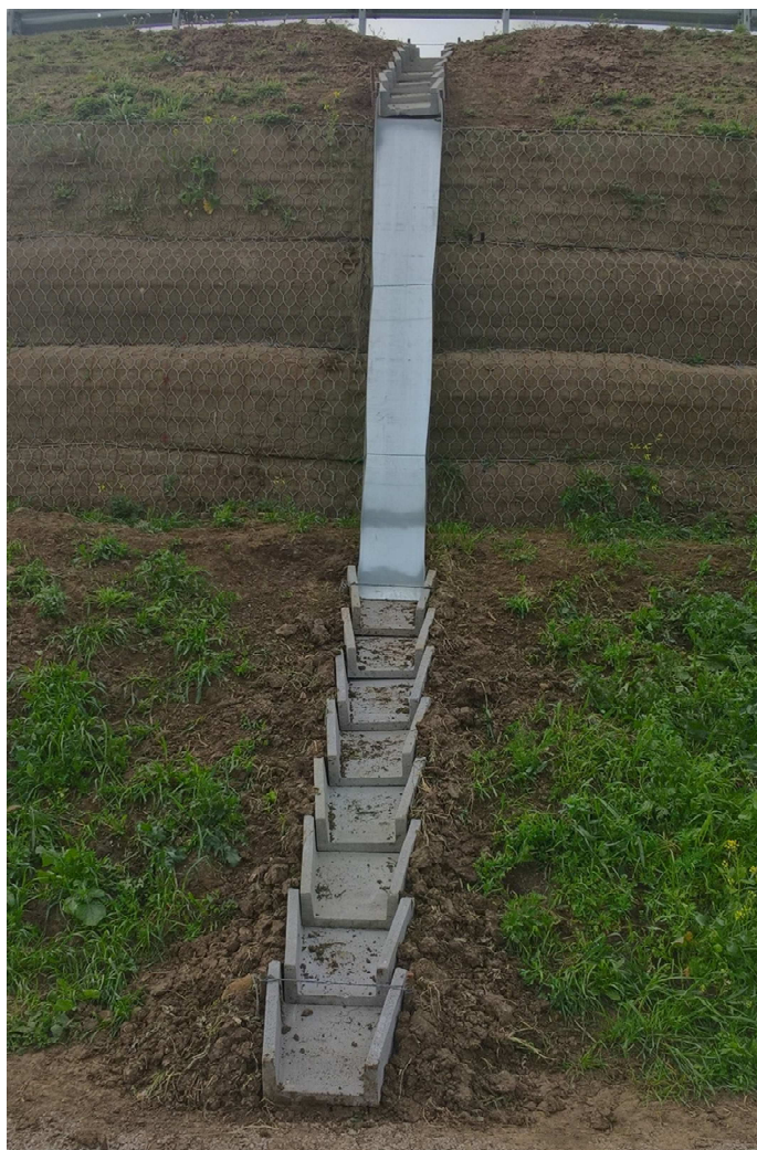
Fig. 39 – Esempio di drenaggio superficiale
