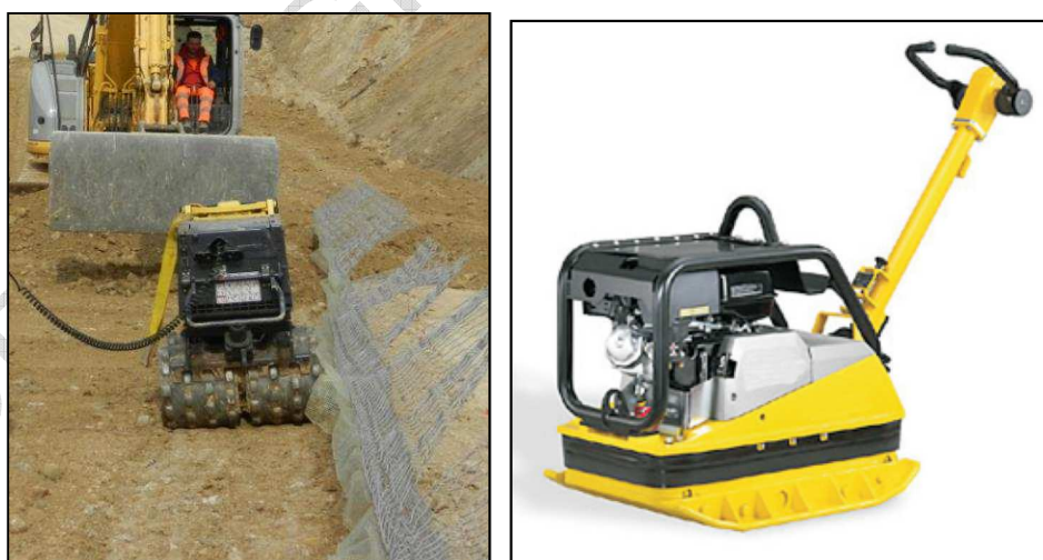
Fig. 28 – Entro 1 m dal paramento devono essere utilizzati compattatori leggeri
