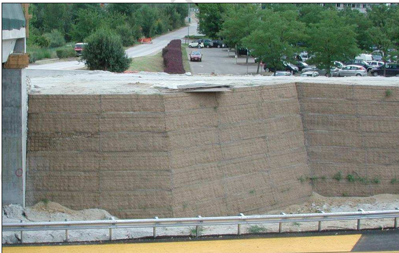
Fig. 32 – Realizzazione di curve concave o convesse
