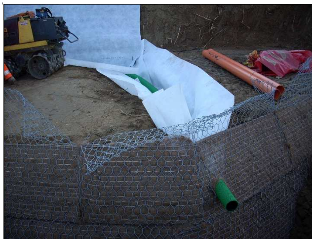
Fig. 38 – Teli di drenaggio per evitare l'accumulo di forze idrostatiche che provocano l'aumento delle pressioni laterali
