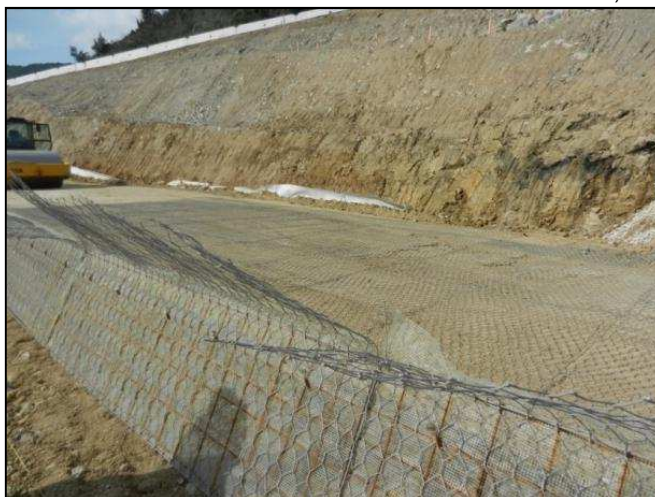
Fig. 20 – Primo strato di TMV pronti per essere connessi tra loro prima del riempimento con il terreno strutturale.
