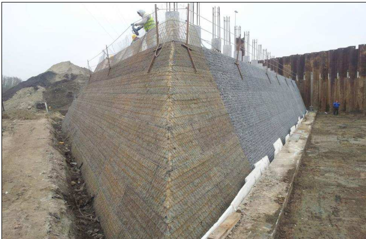
Fig. 33 – Realizzazione di angoli
