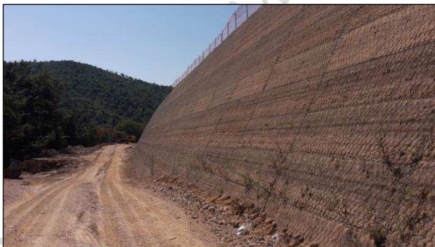
Fig. 21 – Elementi TMV non sfalsati
