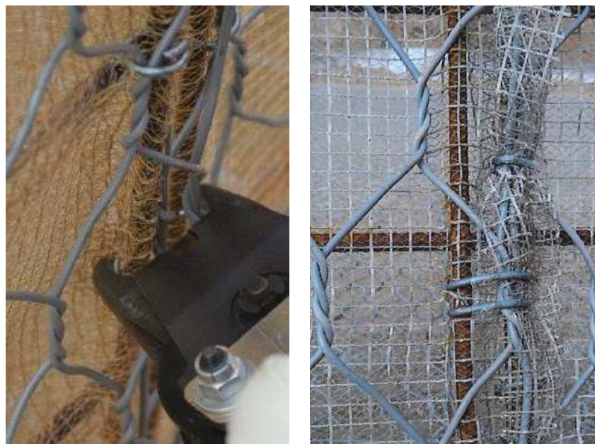
Fig. 13 – Irrigidimento del fronte con l'utilizzo di punti di legatura che collegano i due pannelli elettrosaldati adiacenti al fine di evitare il movimento longitudinale e lo scorrimento delle unità TMV durante la fase di compattazione: 4/5 anelli lungo i bordi laterali assicurano tale collegamento
