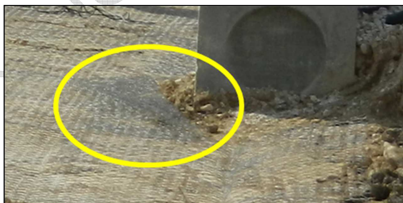
Fig. 18 – In presenza di interferenze, la maglia viene piegata
