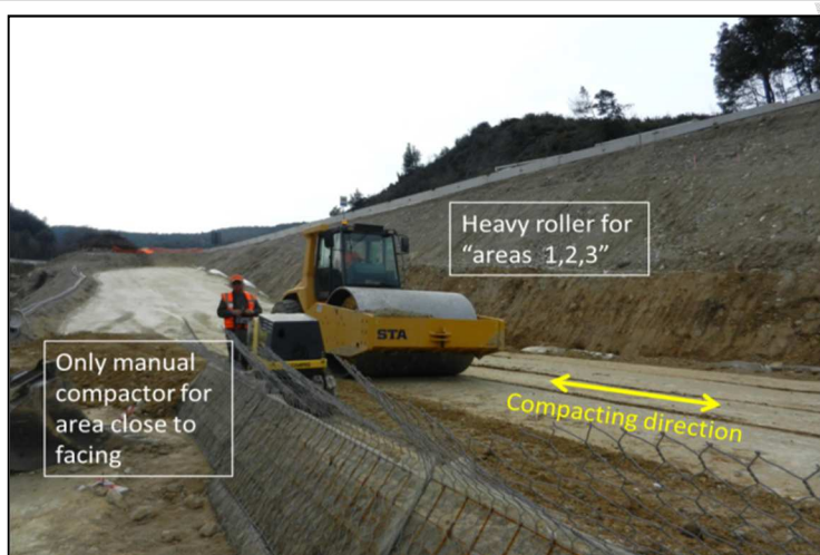
Fig. 27 – Compattazione del terreno strutturale
