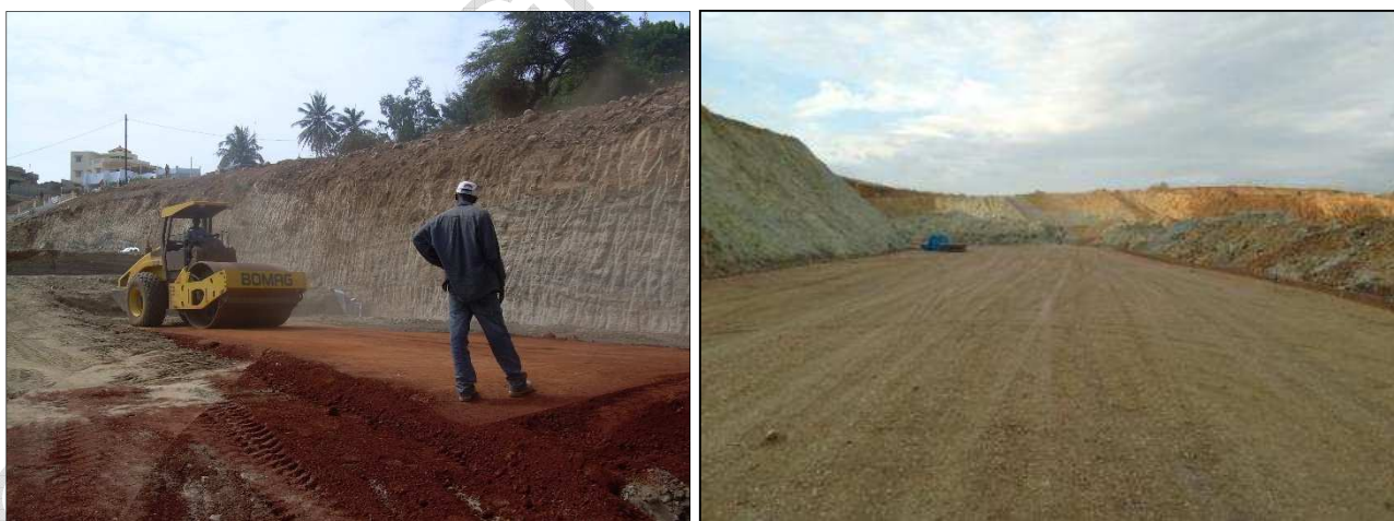
Fig. 6 – Livellamento del piano di posa del TMV
