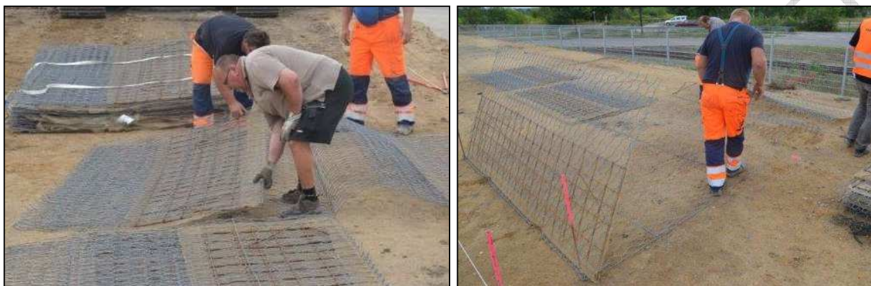
Fig. 8 – Apertura e appiattimento del TMV per ripristinare la forma corretta originale
