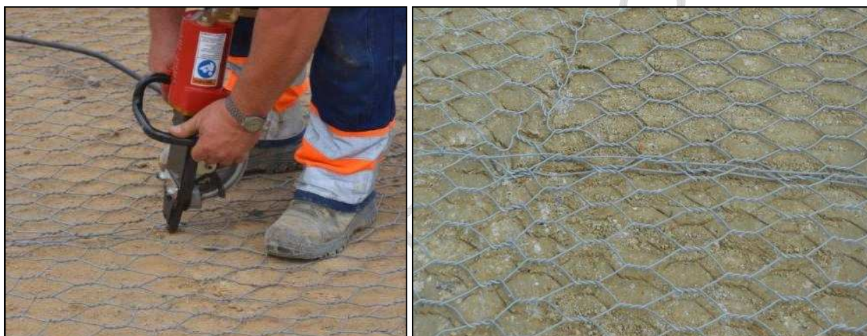
Fig. 17 – Posizionamento dei punti di legatura con graffatrice pneumatica per collegare le code di due elementi adiacenti
