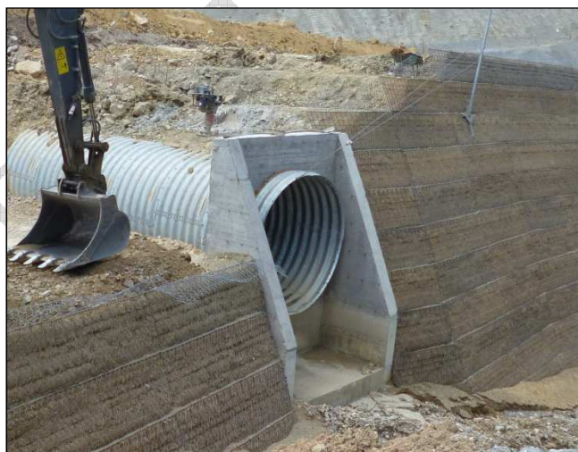
Fig. 35 – Tombino idraulico attraverso i TMV
