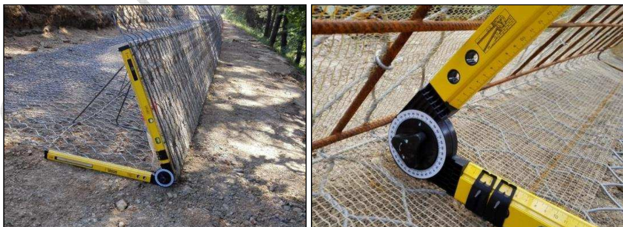
Fig. 11 – Controllo dell'inclinazione del paramento
