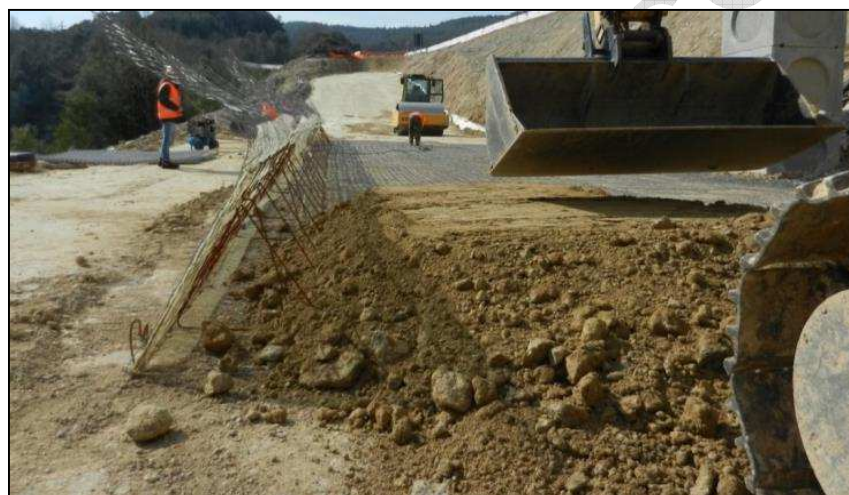
Fig. 26 – Riempimento con terreno strutturale
