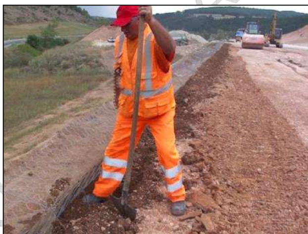
Fig. 30 – Leggera compattazione per il terreno vegetale
