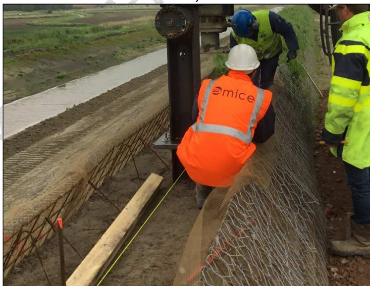
Fig. 37 – Barriera antirumore attraverso il TMV
